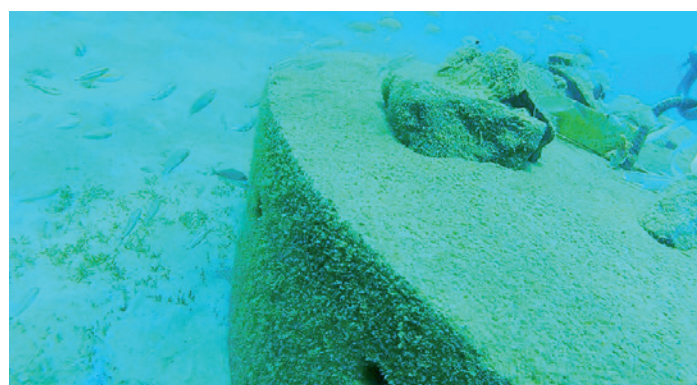
Eco-mouillage - schéma de couplage des fonctions support de corail et habitat pour poissons corallien sur un bloc de béton servant d'ancrage (Guadeloupe, S Pioch, 2014).
